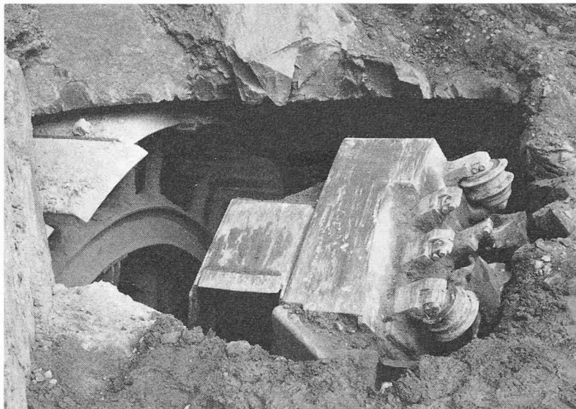
Bild 4. Durchbruch der Wirth TBE IV auf der Nordseite. Das Maschinenchassis befindet sich rechts vom Bohrkopf, welchem der schreitende Einbau unmittelbar folgt
