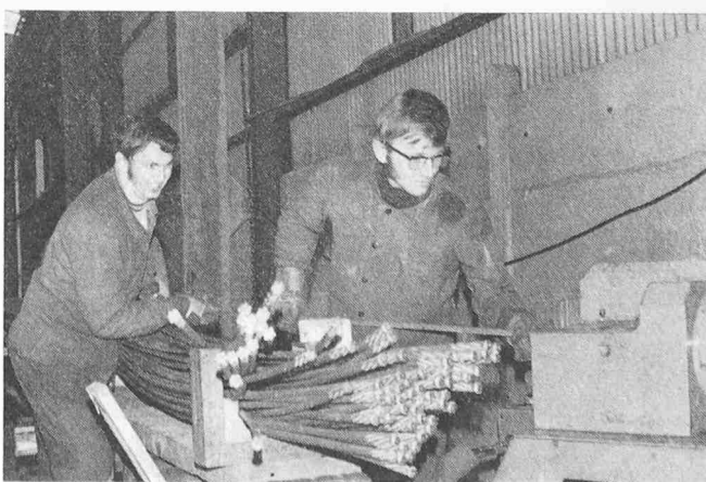
Bild 12. Aufstauchen von BBRV-Köpfen auf Litzen mittels Spezial-Stauchmaschine
