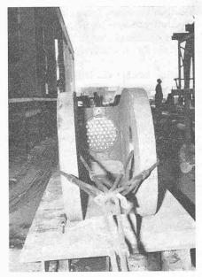
Bild 13. Bündel in gestreckter Lage mit Gabelseilkopf und an die Kopfplatte anliegenden Litzenköpfen, vor Montage des Bodendeckels
