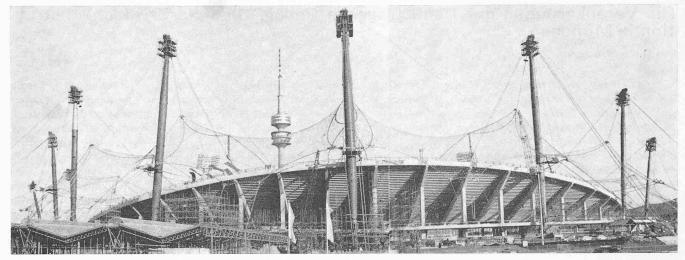
Bild 3. Seilnetzkonstruktion über dem Hauptstadion bei der Aufrichte im November 1971. Alle von den Pylonen ausgehenden Seile sind Haupttragseile
