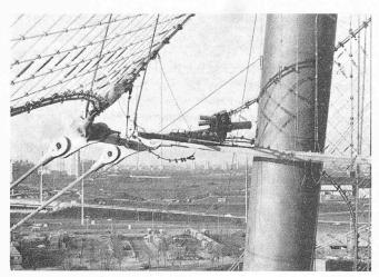
Bild 18. Knotenpunktausbildung zwischen Haupttragseilen und Randseilen mittels Gabelseilköpfen
