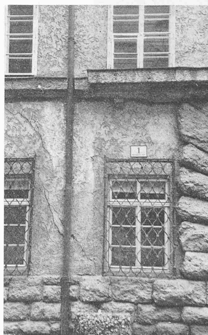
Bild 5. «Behrenstrakt» des Stiftes St. Peter, erbaut 1925/26, von Setzungsrisen durchgezogene Aussenmauer
