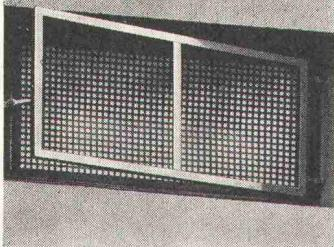
Bild 1 (oben). Holzleiste gemäss Anleitung anschlagen
