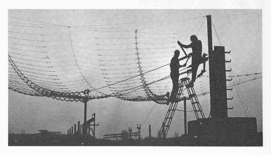
84 Knotenpunkte aufweist. Ebenso viele Motorschaltwerke sind notwendig: Sie schalten die Sender so auf die verschiedenen Antennen, wie es der Sendebetrieb gerade verlangt. Ferner fertigte das Unternehmen für das Wertachtal Steuer- und Messgestelle, 62 Symmetrier- und Transformationsleitungen, über die die von den Sendern erzeugte Hochfrequenz den Antennen zugeführt wird.
