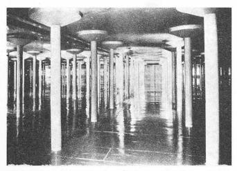
Bild 7. EP-Beschichtung in einem Trinkwasserreservoir
