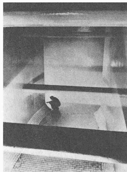
Bild 6. EP-Beschichtung in einer Papierbütte
