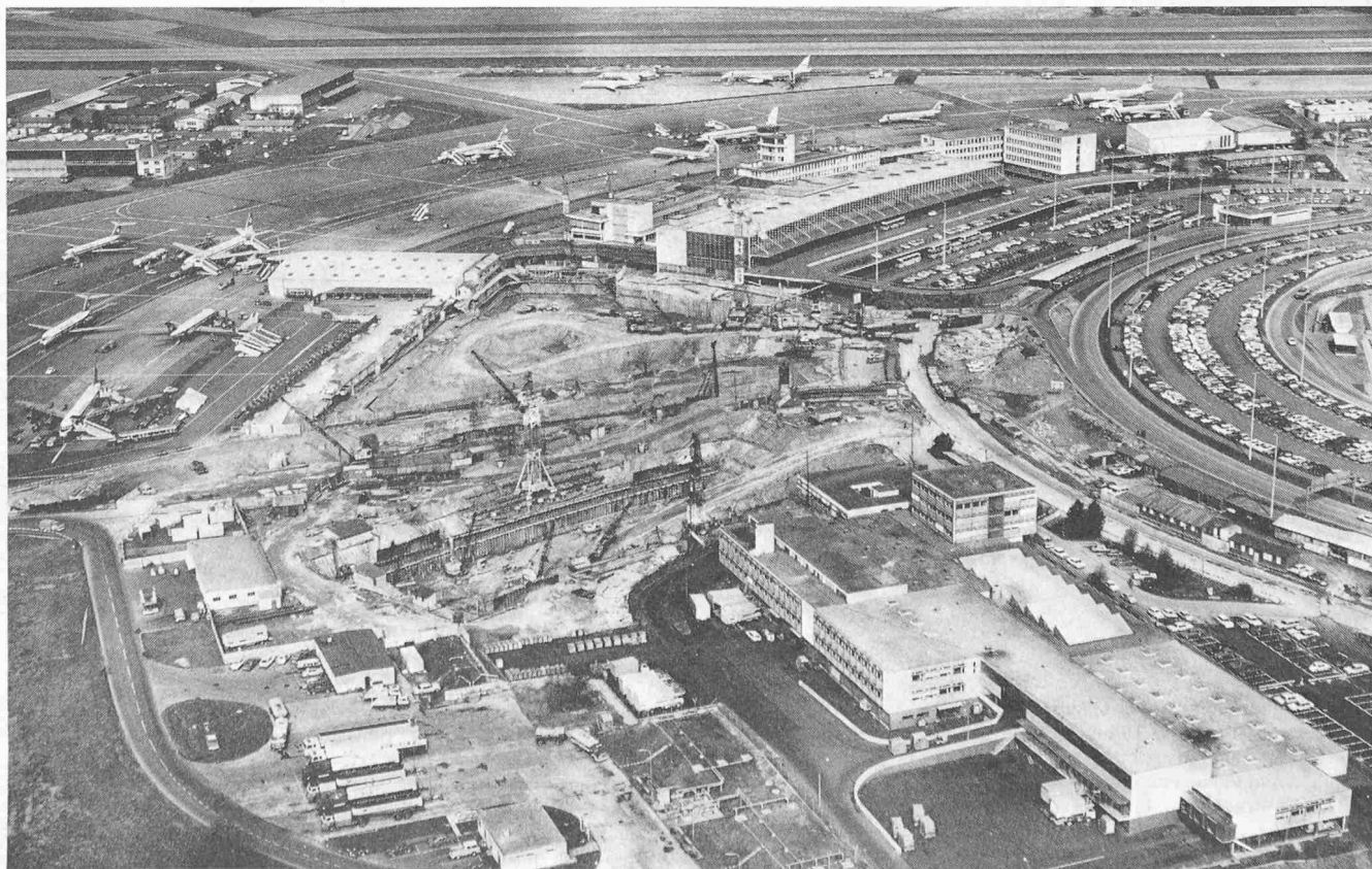
Luftaufnahme des Flughafens Zürich aus Süden. Im Vordergrund das Borddienstgebäude, in Bildmitte die Baustelle der künftigen Station der SBB (im Volksmund «das grosse Loch» genannt). Darüber wird später das erste der im Rahmen der dritten Baustappe geplanten Fingerdocks erstellt. Das Borddienstgebäude wird später den neuen Abfertigungsanlagen weichen müssen. Links neben dem Flughafen die provisorische Abfertigungshalle für Grossraumflugzeuge. Aufgenommen am 6. März 1972 (Photo Comet)
