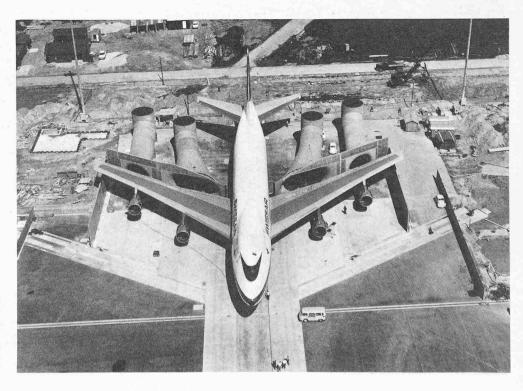
Die Standlauf-Schalldämpferanlage für Grossraumflugzeuge des Typs Boeing 747. Der Vergleich mit Menschen und Personenwagen lässt die Grösse sowohl des Flugzeuges wie auch der Anlagen erkennen (Photo Comet)
