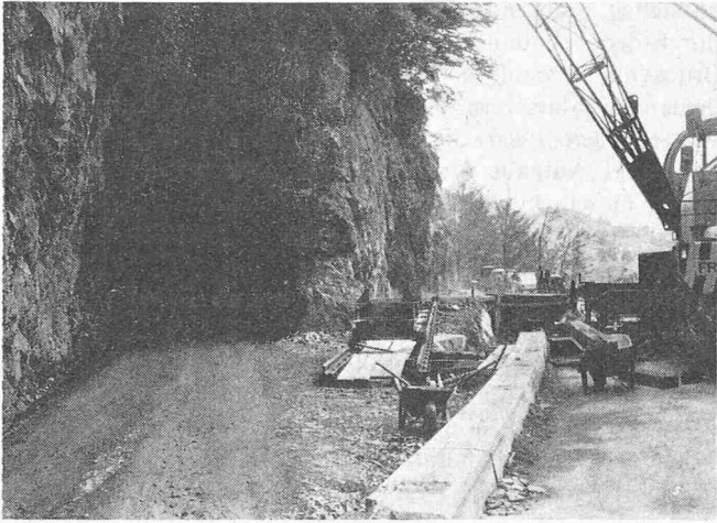
Bild 1 (links). Etwa 2 km von der Ortschaft Seelisberg muss im Rahmen der Gesamtanierung der Staatsstrasse Beckenried—Emmetten—Seelisberg eine Brücke erstellt werden. Sie ersetzt einen schmalen Strassenabschnitt, der durch einen enggekrümmten Tunnel führte. Wenige Meter vor dem durchfahrenen Felskopf sind bereits die ersten 15 m der neuen Brücke erstellt worden (rechts im Bild), die den Engpass talseitig umfährt
