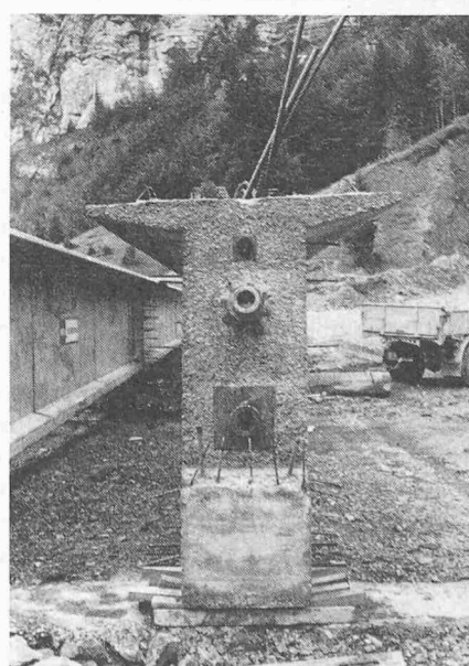
Bild 4 (rechts). Nahtstelle zwischen zwei Trägerhälften. Die vier je 30 m langen Träger für die Überbrückung des grösseren der beiden Spannfelder bestehen aus zwei 15 m langen Teilen. Sie sind aneinandergestossen und mit armiertem Ortsbeton gekoppelt worden.
