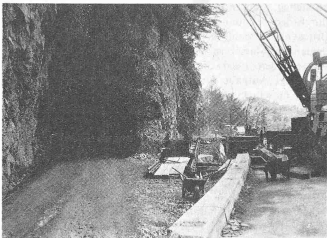
Bild 1 (links). Etwa 2 km von der Ortschaft Seelisberg muss im Rahmen der Gesamtsanierung der Staatsstrasse Beckenried—Emmetten—Seelisberg eine Brücke erstellt werden. Sie ersetzt einen schmalen Strassenabschnitt, der durch einen enggekrümmten Tunnel führte. Wenige Meter vor dem durchfahrenen Felskopf sind bereits die ersten 15 m der neuen Brücke erstellt worden (rechts im Bild), die den Engpass talseitig umfährt
