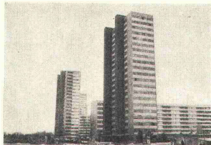
Dichthalten: Tscharnergut, Bern
