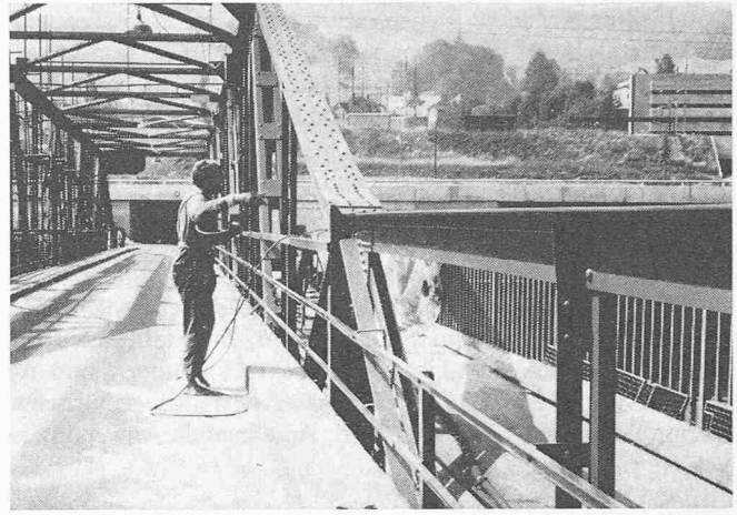
Bild 7. Zweischicht-Lackiersystem für Stahlkonstruktionen
