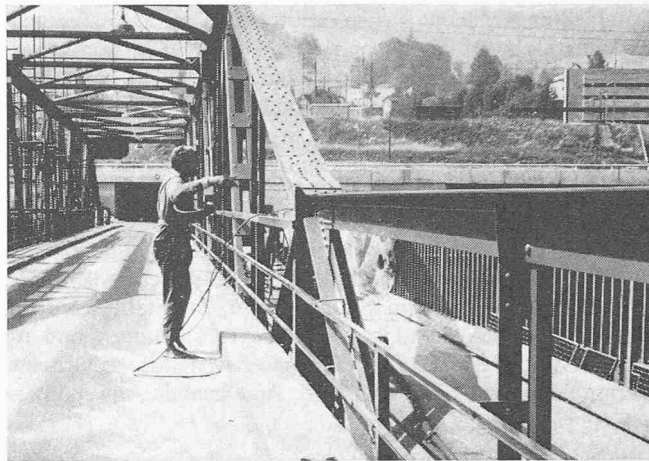
Bild 7. Zweischicht-Lackiersystem für Stahlkonstruktionen
