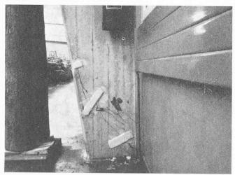
Die Verarbeitungszeit kann innerhalb der wünschbaren Grenzen eingestellt werden. Bei einem Harz- zu-Füllstoff-Verhältnis von 1:2 bis 1:3 können die Mischungen noch injiziert werden. Der Feinheitsgrad des Füllers bestimmt die noch injizierbare Porenweite. Grössere Hohlräume und Poren können statt injiziert auch vergossen werden. Hier empfiehlt es sich, noch mehr Füllstoff beizugeben, dies bis zu einem Verhältnis von 1:5 bis 1:6. Dazu kommen vor allem kornabgestufte Quarzsandgemische in Frage.
