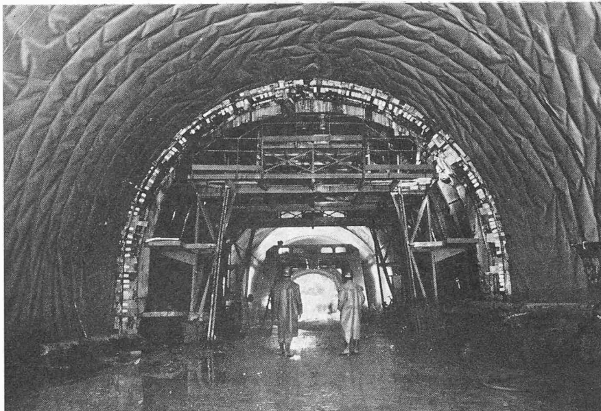
Bild 2. Gotthard-Strassentunnel. Schalung für den Auskleidungsbeton im Bereiche der isolierten Lockergesteinsstrecke beim Nordportal
