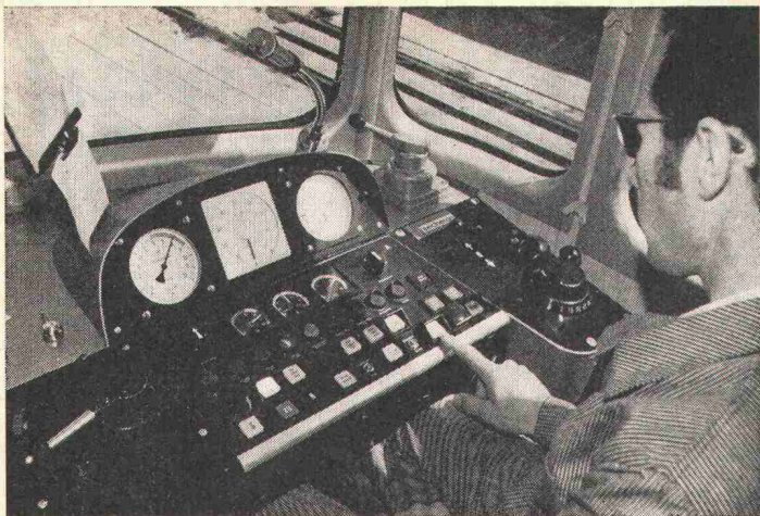
Das Anzeigegerät der elektronischen Hasler-Geschwindigkeitsmessanlage zeigt dem Lokführer die Ist- und die Sollgeschwindigkeit an
