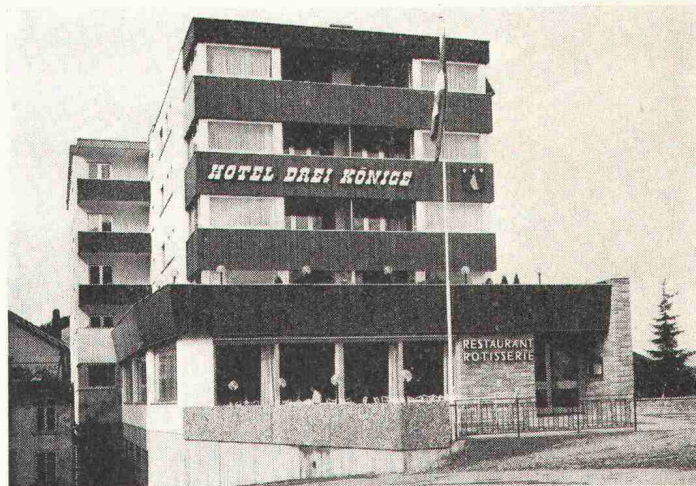
Bild 1. Fassade des Hotels Drei Könige in Einsiedeln mit Werzalit-Täfelung
