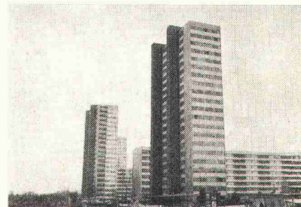
Dichthalten: Tscharnergut, Bern
