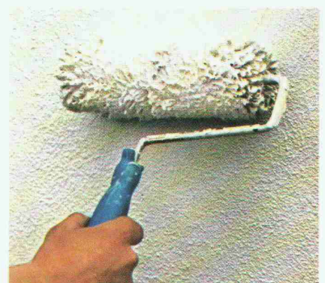
Schlußbeschichtung mit Herbol-Latex-Hochglanzfarbe
