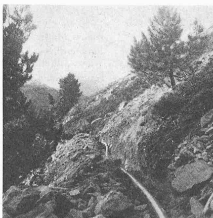
Bild 2. Der offene Graben mit eingelegter Weichpolyäthylenleitung. Alp von Gspon
