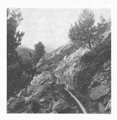
Bild 3. Auch bei grossen Blöcken und felsiger Grabensohle können die Weichpolyäthylenrohre verwendet werden. Alp von Gspon
