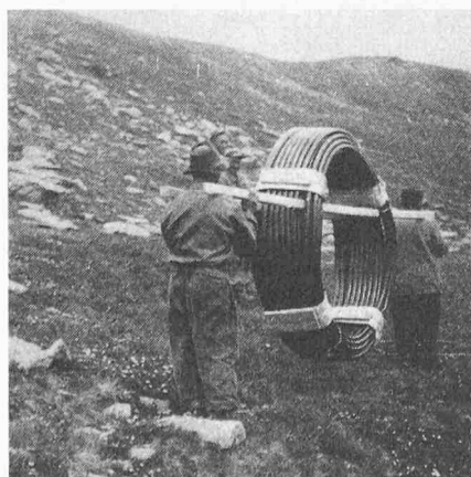
Bild 4. Transport einer Rolle Polyäthylenrohre von 200 m, Durchmesser 50 mm, in den Bergen
