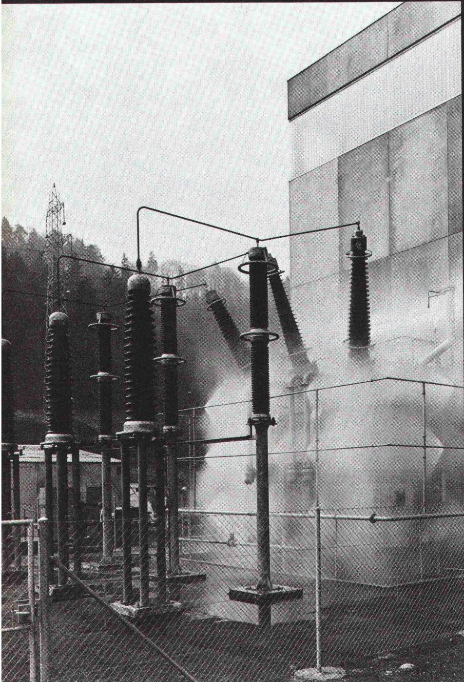
Sprühflutanlagen von SIFRAG dienen der wirksamen Bekämpfung von Bränden leicht entzündlicher Stoffe, die ein explosionsartiges Ausbreiten des Feuers befürchten lassen. Der gesamte Bereich wird schlagartig unter Wasser gesetzt, wobei ein dichter Wassernebel erzeugt wird, der die Sauerstoffzufuhr unterbindet. (Hierin liegt der entscheidende Unterschied zu Sprinkleranlagen, deren Lösch Einsatz auf den Brandherd beschränkt bleibt.)
