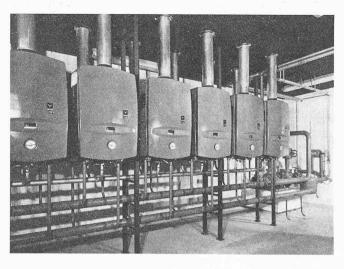
Bild 2. Die beiden Überdruckkessel in der Heizzentrale des Kunstgewerbeschulhauses Schänzlihalde, Bern, mit ihren Gasgebläsebrennern. Seitlich der Brenner sind die Flammenüberwachungsorgane angeordnet, während an der zum ersten Brenner führenden Gasleitung die Gasdruckwächter und die Sicherheitsorgane für die Haupt- und Zündgasventile zu sehen sind. Gesamtleistung 1,6 Mio kcal/h
