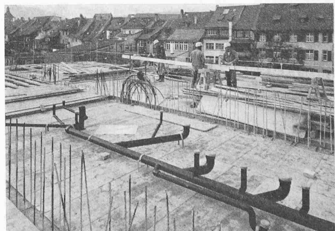
Bild 1. Vorgefertigte Kunststoff-Ablaufleitungen aus Hartpolyäthylen (Akatherm) auf einer Schalung montiert
