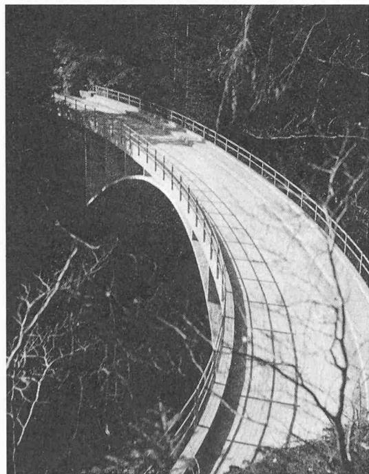
Schwandbachbrücke bei Schwarzenburg, Spannweite 37 m, Grundriss elliptisch. Erbaut 1933
