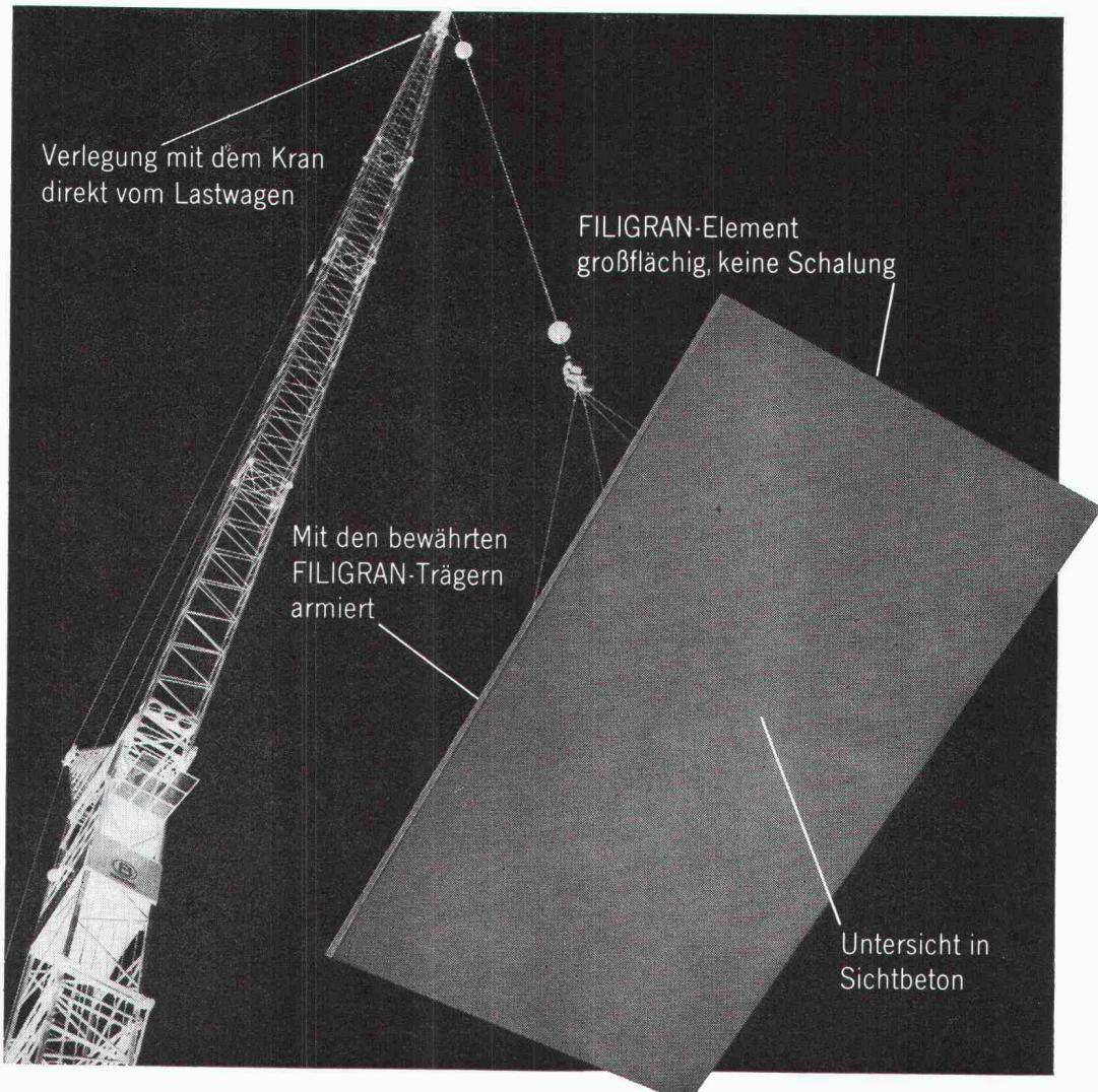
Das FILIGRAN-Element ist ein großflächiges, armiertes Deckenfertigteile. Es ermöglicht den Bau einer Massivdecke ohne Schalung mit Sichtbeton-Untersicht. Mehrere Arbeitsgänge entfallen.
