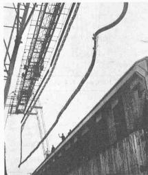
Bild 3. Das GINA-Profil bei der Montage
