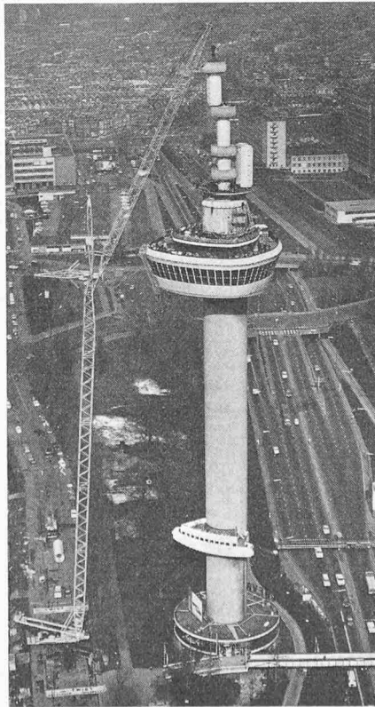
Bild 2. Der Euromast während der Montage des 75 m hohen Raumturmes
