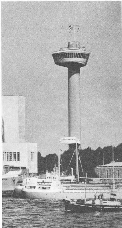
Bild 1. Ansicht des Euromastes in Rotterdam vor der Aufstockung
