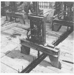
Bild 3. Arbeitsplattform mit Gerüstjoch, Hubeinrichtung und Kletterstange
