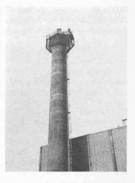
Bild 4. Das konische Hochkamin, 100 m hoch, für die Kehrichtverbrennungsanlage in Colombier wurde in einem Monat hochgezogen
