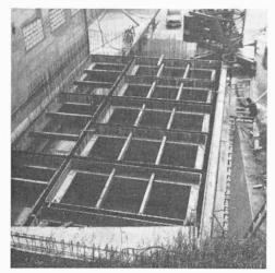
Bild 2. Vorbereiten der Gleitschalung für einen 26 m hohen Siloanbau auf der Fundamentplatte. Der Getreidesilo der Landwirtschaftlichen Genossenschaft Küssnacht am Rigi wurde in einer Woche hochgezogen
