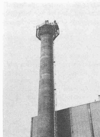
Bild 4. Das konische Hochkamin, 100 m hoch, für die Kehrlichtverbrennungsanlage in Colombier wurde in einem Monat hochgezogen
