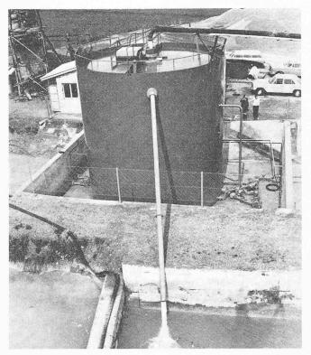
Bild 2. Schlammwasser-Kläranlage Typ Ka $75~{\rm im}$  Betrieb. Schlammwassermenge  $3500~1/{\rm min},$  Wasseroberfläche 44 m², Höhe 8,53 m, Durchmesser 7,50 m
