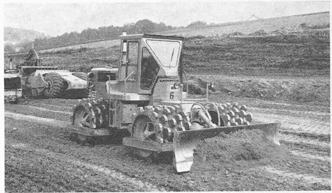
Bild 1. Einsatz des Cat-Verdichters 815 auf der N 12. Mit dem Schaufelblatt kann der Verdichter das Schüttmaterial selbst verteilen und ausgleichen
