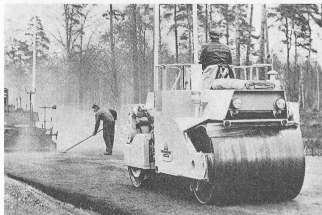
Bild 8. Selbstfahrende Tandem-Vibrationswalze Dynapac CC 40 mit Knicklenkung und fünf verschiedenen Amplituden-Stufen für Erd- und Asphaltverdichtung, Gewicht 10 200 kg, mit Deutz-Dieselmotor von 92 PS
