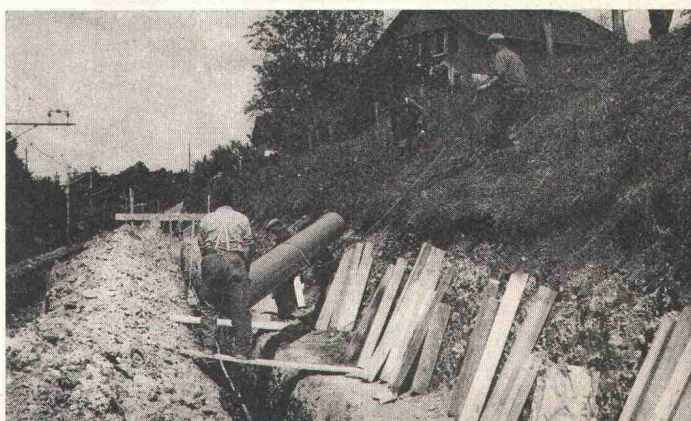
KALIDUR-Kanalisationsrohre, verlegt im Bahneinschnitt
