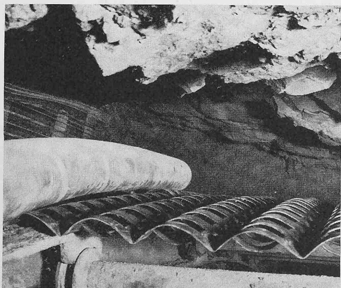
Bild 3. Zwischen Fels und Blechen wird Pumpbeton eingebracht
