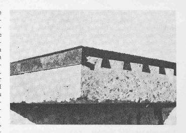
benschwanz-Profilen (Bild) im Beton vergossen ist, nimmt die Fallenergie sanft auf. Durch eine strukturierte Oberfläche wird die Rutschgefahr selbst bei Regen wesentlich verringert. Die neuen Gummi-Beton-Sicherheitsplatten sind abriebfest, streusalz- und motorölbeständig. In den Massen  $50 \times 50 \times 5$  cm werden sie dunkelgrau und dunkelrot geliefert. Zur Verlegung ist, wie bei allen anderen Gehwegplatten, lediglich ein Sandbett erforderlich. DK 625.815.5:678
