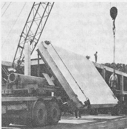
Bild 2. Kippen einer Deckenplatte am Transportfahrgestell (Gewicht der Platte rund 12 t)
