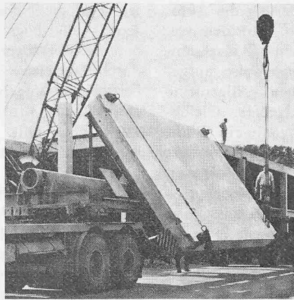
Bild 2. Kippen einer Deckenplatte am Transportfahrzeug (Gewicht der Platte rund 12 t)
