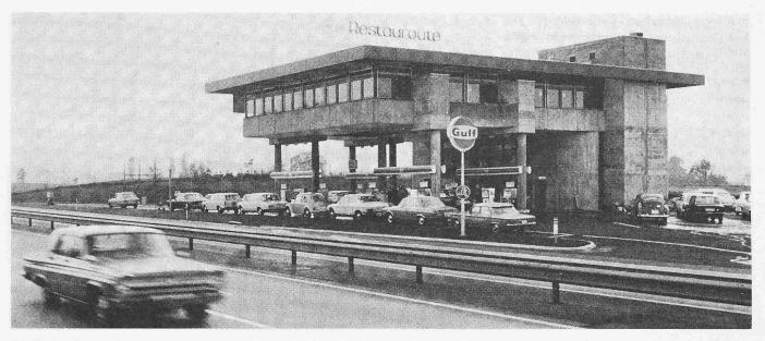
Die Tankstelle und Raststätte «Restauroute 3-Stern» Kölliken-Nord an der N 1 Zürich—Bern. Die Anlage enthält im vertikalen Trakt vier Geschosse. Das die Tankstelle überkragende 4. Geschoss enthält den Restaurationsbetrieb (eine Cafeteria befindet sich im 1. Stock). Im Parkraum können 74 Wagen abgestellt werden.
