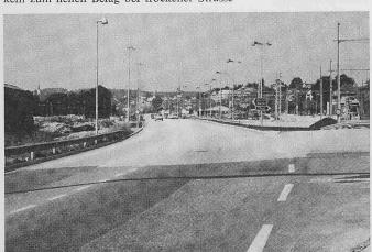
Von Interesse sind die lichttechnischen Angaben über die Versuchsstrecke Worblaufen (Tabelle 1), wo ein Asphaltbetonbelag der Sorte AB 10 von 3 cm Dicke mit einem Maximalkorn von 10 mm und einem auf 6,4 bis 6,6 Gewichtsprozent erhöhten Bindemittelgehalt eingebaut wurde.
