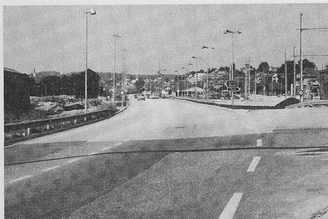
Bild 2. Gleiche Stelle wie Bild 1, aber bei Tag. Übergang vom dunkeln zum hellen Belag bei trockener Strasse
