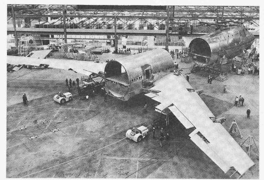
Bild 1. Blick in die Montagehalle der Boeing-Werke. Der Rumpfmittelteil einer Boeing 747 mit den Tragflächen wird von zwei Schleppern an den Vorderteil herangeschoben
