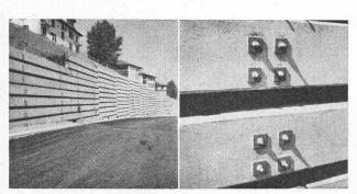
Verankerung von Beton-Elementen in Bohrpfählen mit Felsanker AREFIX.
