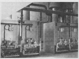
Bild 3. Installationsschema der Gasheizung der SKA-Filiale Seefeld. Der Anschluss an die bestehende Heizung wurde im Keller vorgenommen, da hier von der alten ölheizung her der Verteiler vorhanden war. Von hier aus wird das Warmwasser in die bestehenden Radiatoren transportiert. Die von der Heizzentrale direkt belieferten Vorwärmer bedienen die Schalterhalle und den Keller mit Warmluft
