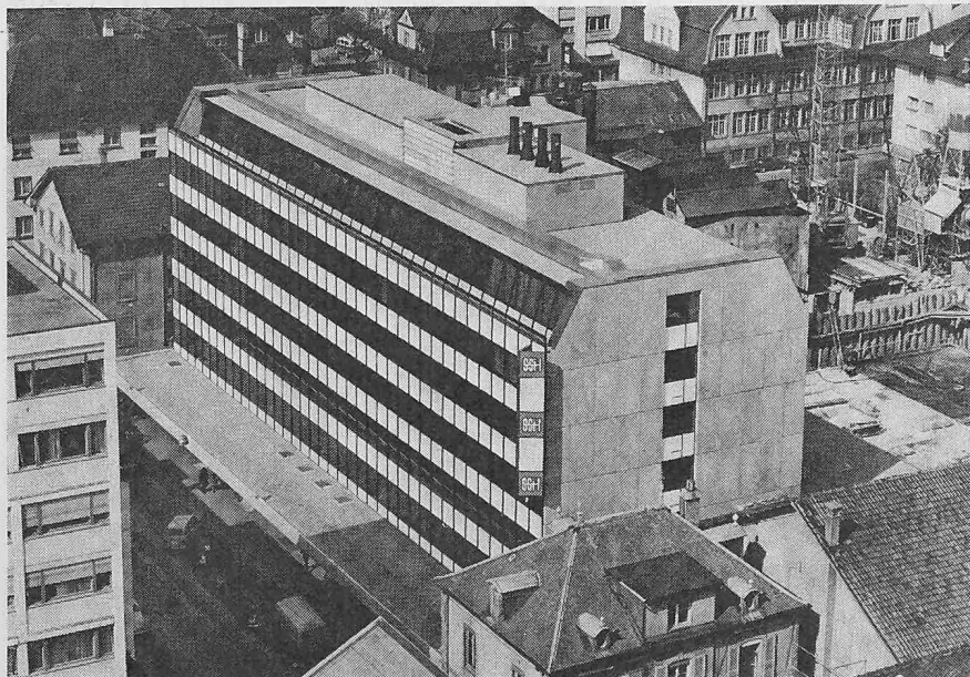
Bild 5. Die grösste mit Gas befeuerte Dachheizzentrale der Schweiz befindet sich in der ersten Etappe des Geschäftshauses und Shopping Centers Biel. Rechts die Baugrube der zweiten Etappe dieses Komplexes, die über eine Dachheizzentrale mit einer Leistung von 1,65 Mio kcal/h verfügen wird. Vorne auf dem Dach ist die Heizzentrale mit ihren vier Abgaskaminen zu sehen (Photo Anag)
