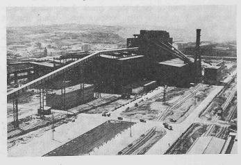
werk gelangen herkömmlich vergossene Rohblöcke zur Blockbrammenstrasse, die ihrerseits die Knüppel- und die Profilstrasse in erster Hitze mit Vorblöcken und ausserdem die Grobblechstrasse in zweiter Hitze mit Vorbrammen versorgt. Die in einer Tiefofenanlage auf Walzhitze
