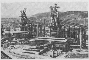
Bild 2. Sauerstoff-Blasstahlwerk. Vorhanden sind drei Sauerstoffblas-Konverter mit einer Kapazität von je $110\,\mathrm{bis}\,125\,\mathrm{t}$
