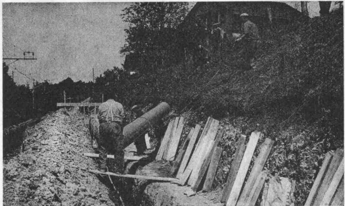
KALIDUR-Kanalisationsrohre, verlegt im Bahneinschnitt
