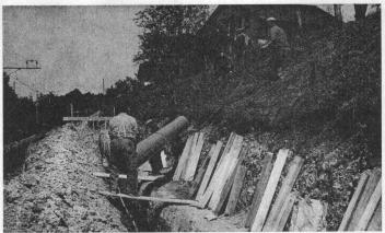
KALIDUR-Kanalisationsrohre, verlegt im Bahneinschnitt
