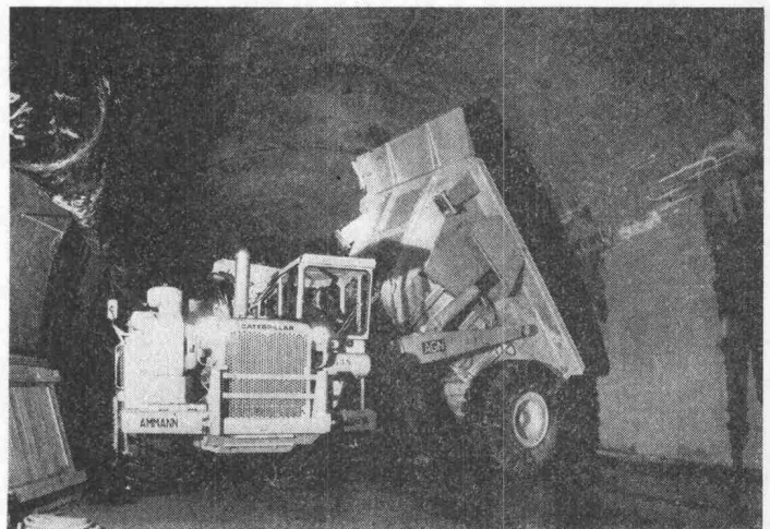
Bild 1. Durch Aufkippen der Benne verkürzt der Caterpillar-Rückwärtskipper 621PR seinen Radstand, was ihm ein Wendemanöver auf den ersten Antrieb ermöglicht
