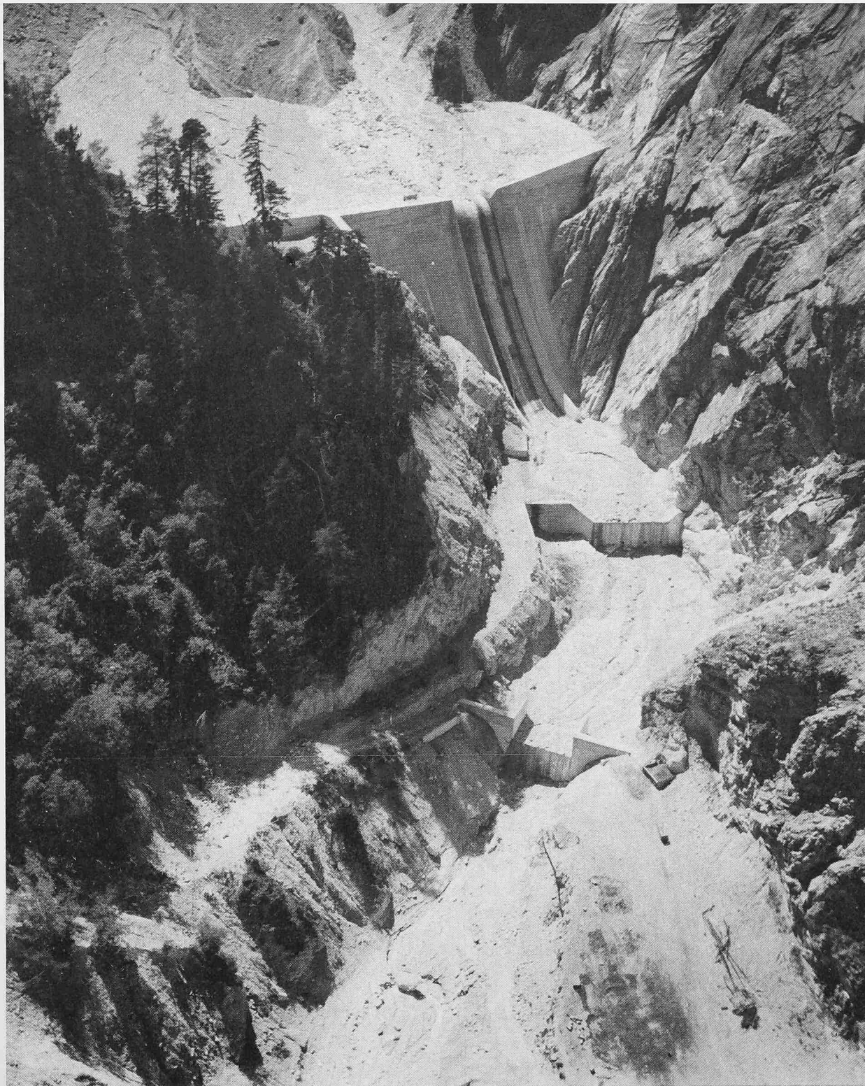
Flugaufnahme der Illgrabensperre vom 19. 7. 1971. Der Staustamm hat sich schon nach sehr kurzer Zeit mit Bachschutt aufgefüllt. Im Vordergrund die beiden Schwellen 2 und 3 (Photo C. Schum, Muri BE)
