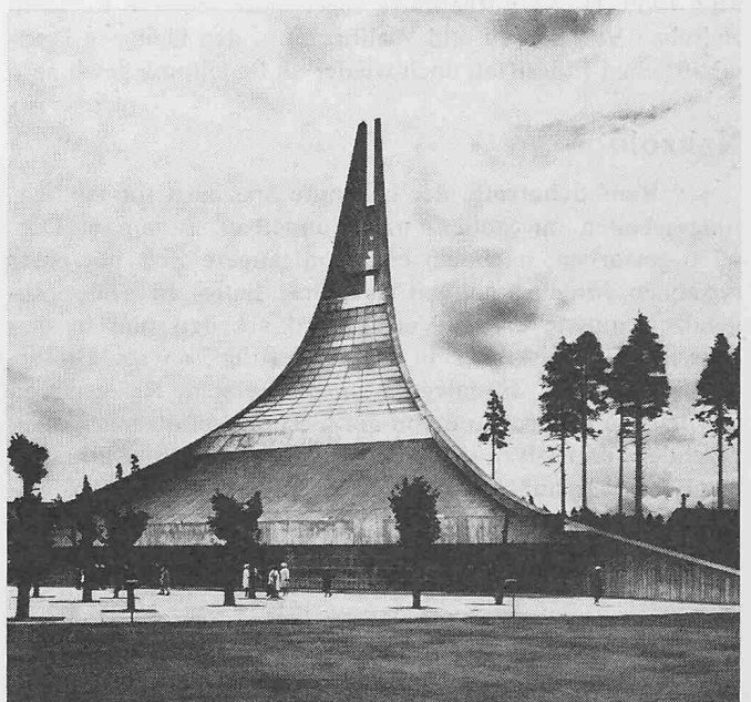
Bild 1. Evangelische Kirche in Lauritsala, Finnland. Das Dach weist über 180 m 2 Dreischeibenglas auf
