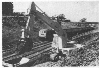
Bild 1. Der JCB-Raupenbagger Typ 7 B mit Hochlöffel im Einsatz
