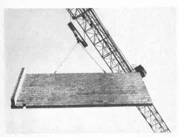
Bild 1. Krane bringen die Elemente ab Lagerplatz oder Lastwagen an den Einsatzort
