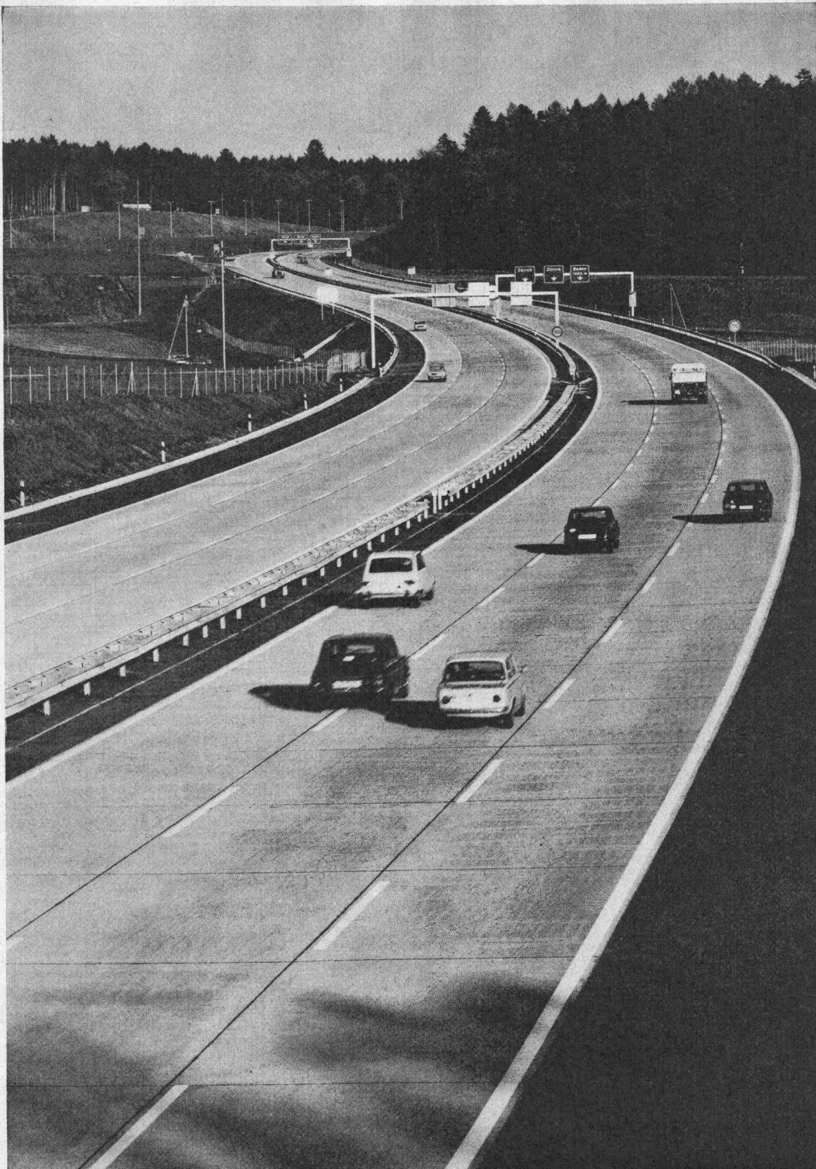
Nationalstrasse N 1 Bern — Zürich im Kanton Aargau Betonbelag
