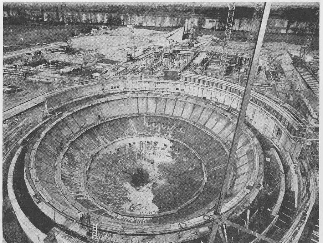
Bild 3. Grossbaustelle des Kernkraftwerkes Biblis. Erster Bauabschnitt mit der unteren Hälfte der aus 542 Blechsegmenten und zwei Kalotten zusammengesetzten Stahlkugel. Sie liegt in Endzustand in einer Betonmulde, deren tiefster Punkt sich 6 m unterhalb der Erdoberfläche befindet (Werkphoto Krupp)
