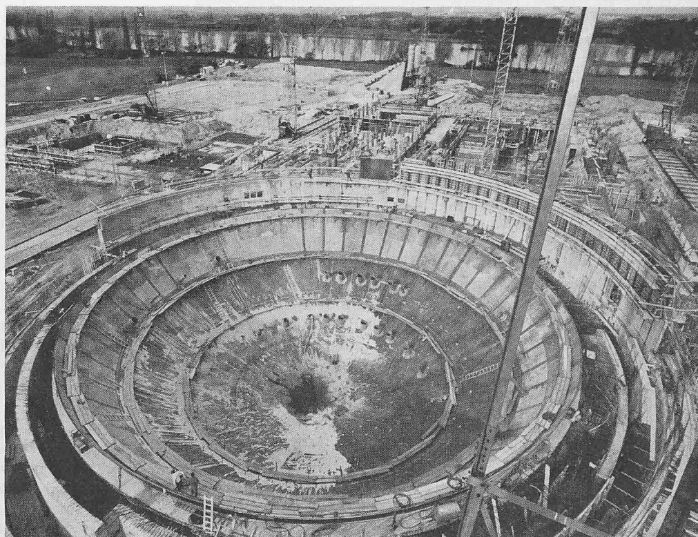
Bild 3. Grossbaustelle des Kernkraftwerkes Biblis. Erster Bauabschnitt mit der unteren Hälfte der aus 542 Blechsegmenten und zwei Kalotten zusammengesetzten Stahlkugel. Sie liegt im Endzustand in einer Betonmulde, deren tiefster Punkt sich 6 m unterhalb der Erdoberfläche befindet (Werkphoto Krupp)
