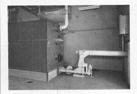
Vollständig geschlossene mechanische Anlagen mit Tagesbunker oder automatischer Siloaustragung mit stufenloser Leistungsregulierung. Wirtschaftliche Verbrennung nach dem Prinzip der Unterschubfeuerung mit separatem Verbrennungsluftventilator, daher rauchlose Verbrennung und keine Flugasche. Feuerunterhaltsautomatik. Mit Wahlschalter umstellbar auf Oelfeuerung. Automatische Brandschutzsicherungen.
