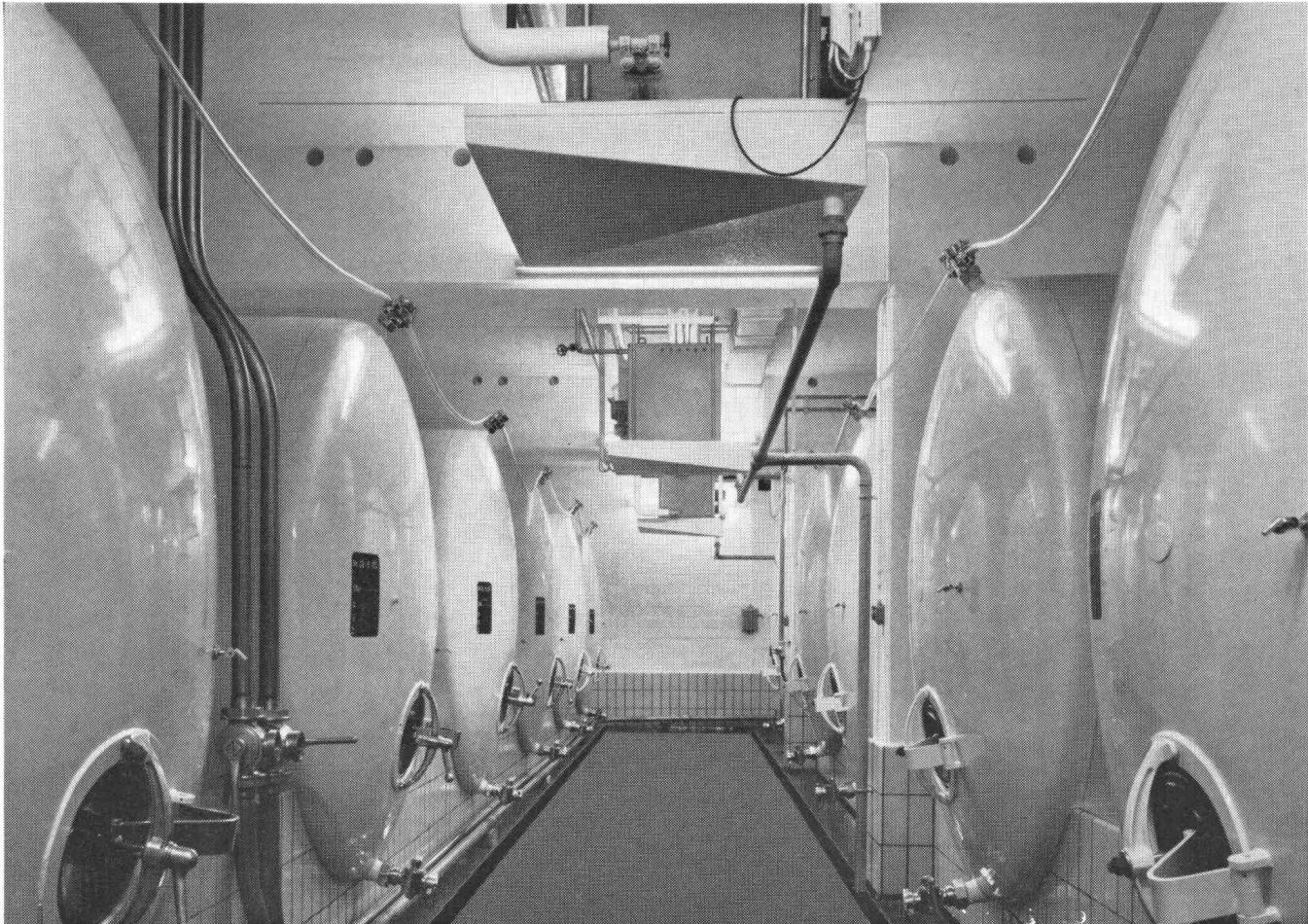
Anlagen für die vollständige Kälte- und Wärmeversorgung ganzer Brauereien. Hier Lagerkeller mit drei Deckenluftkühlern bei der Ankerbrauerei AG in Frenkendorf, Schweiz.
