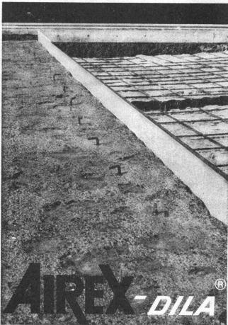
Dilatationsfugen-Einlage AIREX® Brückenanschluss Nationalstrasse N 1
