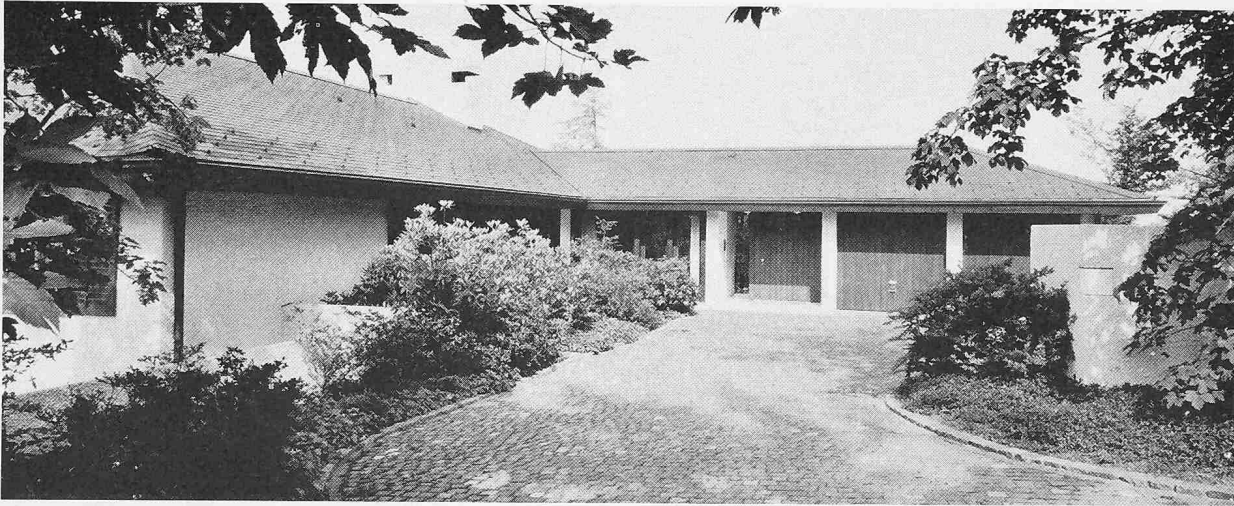
Ostansicht: Garage mit Hauseingang (Obergeschoss)
