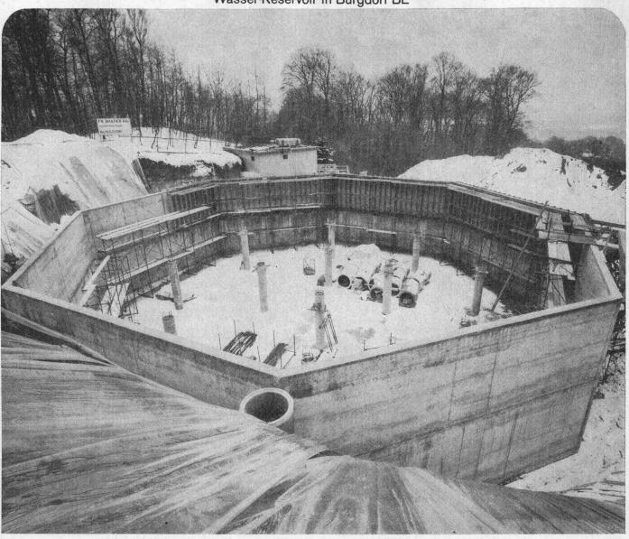
Ein Vieleck mit System zu schalen ist eine Aufgabe, die mit der cobe®-Normschalung rationell gelöst werden kann. Die einzelnen Normelemente werden in
