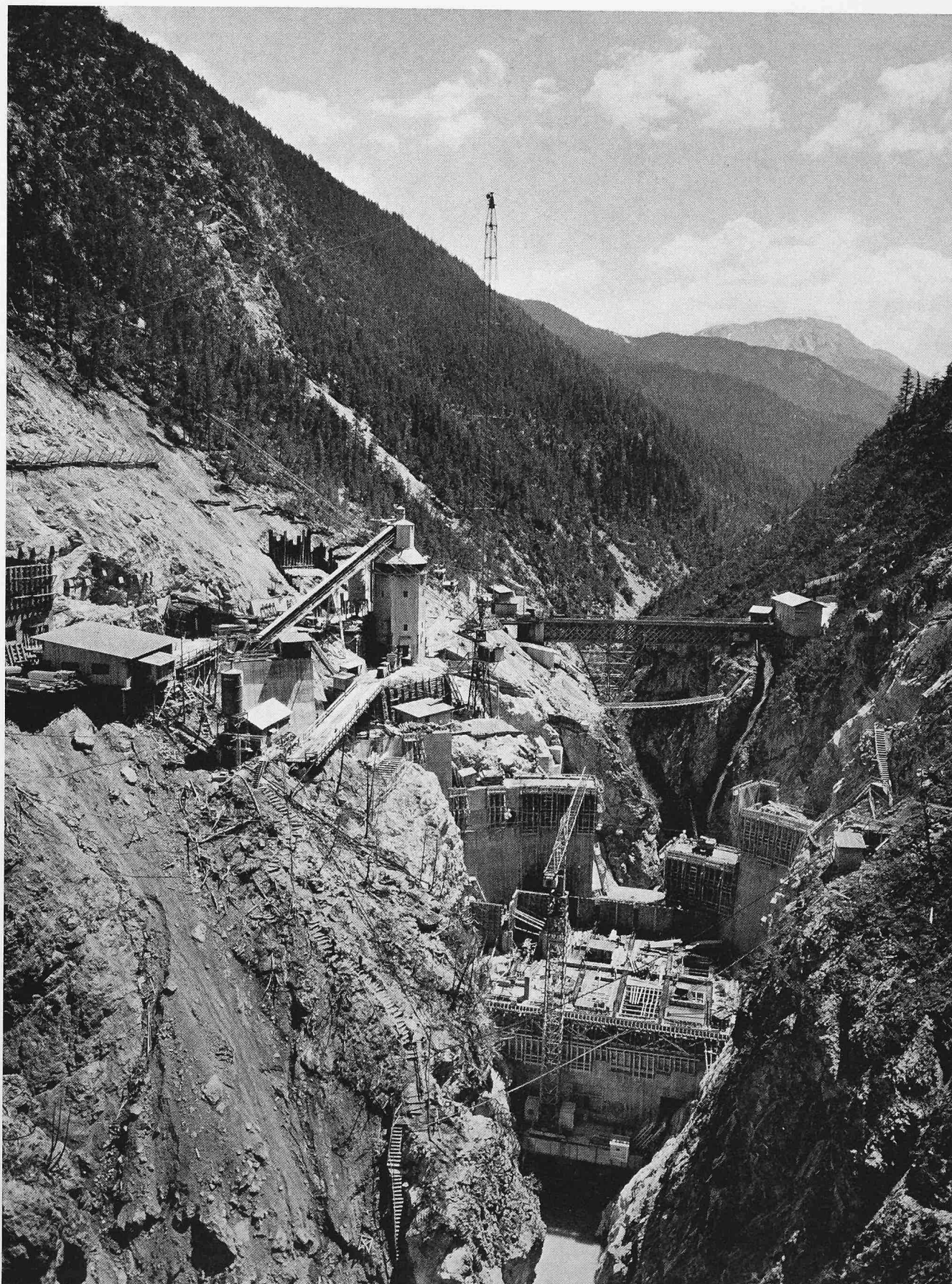
Baustelle Ova Spin im Juli 1967. Links die Betonfabrik, die Betonverladerampe durch die Flügelmauer und der 360-mt-Derrick. Im Hintergrund die Dienstbrücke zur Ausmündung des Freisiegelstollens von S-chanf her (Foto Feuerstein)
