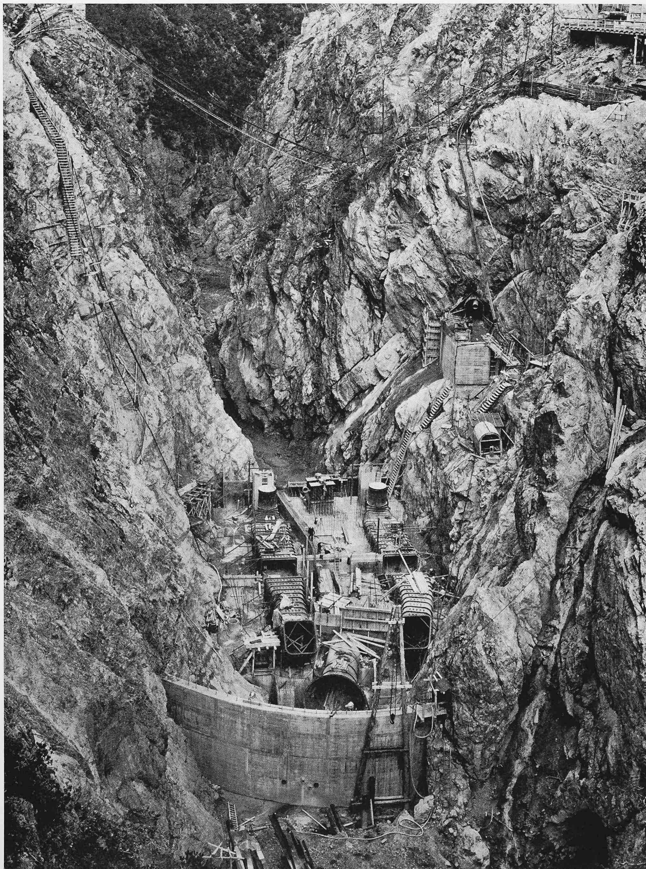
Montage der Saugrohre und des gekrümmten Mauerdurchlasses im Fundamentsockel im August 1966. Im Vordergrund der oberwasserseitige Fangdamm und, ganz rechts, der Einlauf zum Umleitstollen. Im Hintergrund die luftseitige Verengung der Spölschlucht (Foto Feuerstein)
